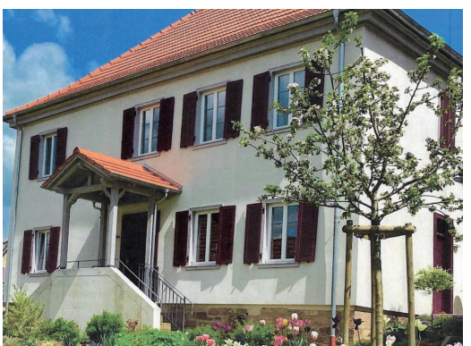
Beispiel für eine gelungene Sanierung in Wegfurt (Preisträger 2021) Foto: Holger Heine
